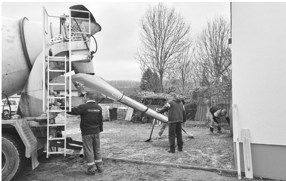
A kocsibehajtó betonozását is a községi vállalat alkalmazottai végezték Archiv fotó
